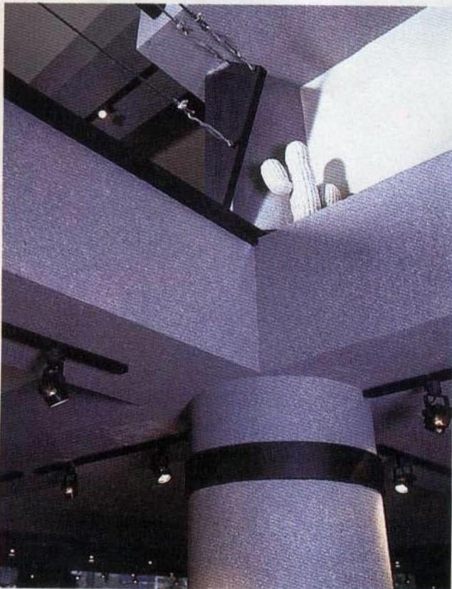
*Las paredes y columnas fueron pintadas con pintura policromada en dos tonos. El diseño del barandal fue estructurado con unas piezas hechas de tubo de sección cuadrada, forradas con metal barrenado y unidas entre sí con cable de acero tensado. El pasa manos es de tubo de sección redondo de tres pulgadas. Las traveses estructurales se remarcan para jugar con los techos.*
