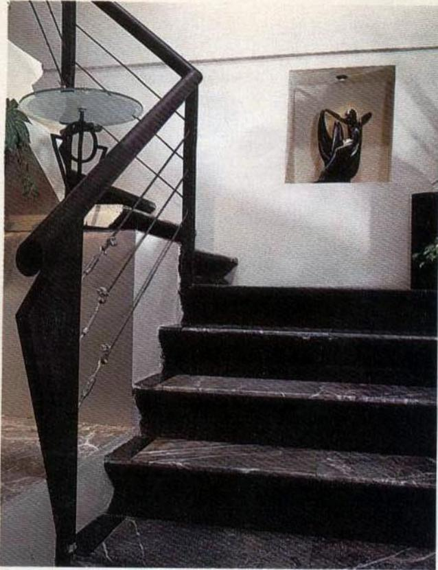
*Para lograr que la gente subiera al segundo piso, se giró la primera rampa de la escalera dejándola así como elemento central del local. Las huellas son de mármol gris tepeaca y cintilla en mármol negro monterrey.*
